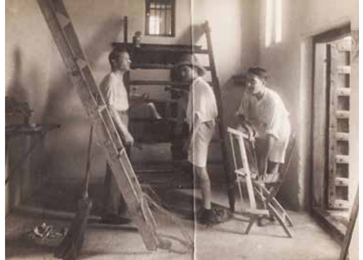
Il piccolo alloggio di Aurelio, nel quartiere arabo di Chisimaio. A sinistra il nostro concittadino mentre, con l'aiuto di due colleghi, dà una mano di bianco alle pareti.
