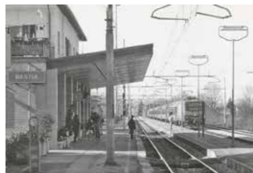
La stazione con il terzo binario, 2006
