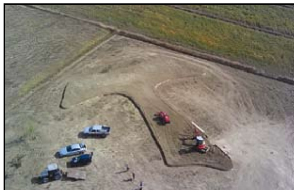
Piandarca. Lavori per la realizzazione del grande TAU
