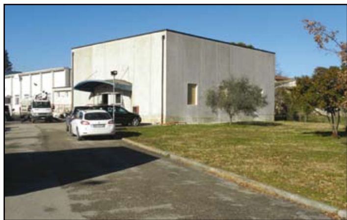
Edificio della Scuola Elementare. In primo piano la palestra, dove si lavora per ricavarne aule
