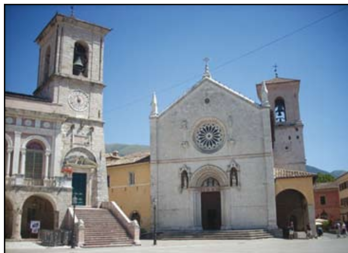
Norcia - Basilica di San Benedetto prima del terremoto del 30 ottobre
