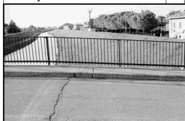
La spaccatura del ponte prima che venisse ricoperta con manto bituminoso.
