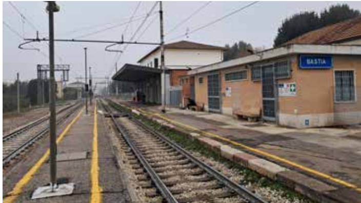
La stazione, oggi, oggetto di interventi RFI
